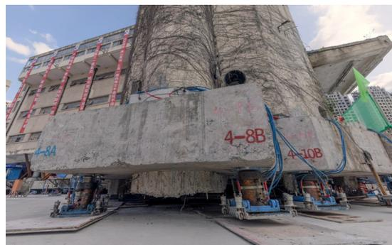
(b) Edificio desplazado usando patas robóticas.
